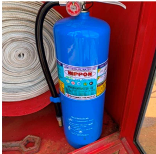
รูปที่ ข-23 ถังดับเพลิงแบบมือถือชนิด ABC Chemical อยู่ภายในตู้เก็บบริเวณปลายท่า
