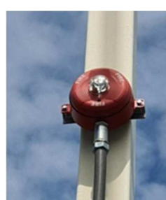
รูปที่ ข-33 อุปกรณ์แจ้งเตือนเหตุเพลิงไหม้และอุปกรณ์ตรวจจับ
