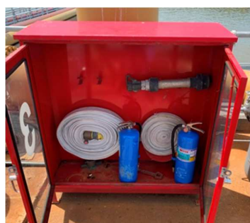
รูปที่ ข-22 หัวจ่ายน้ำดับเพลิงและสายยางขนาด 2.5 นิ้ว อยู่ภายในตู้ Hydrant บริเวณปลายท่า
